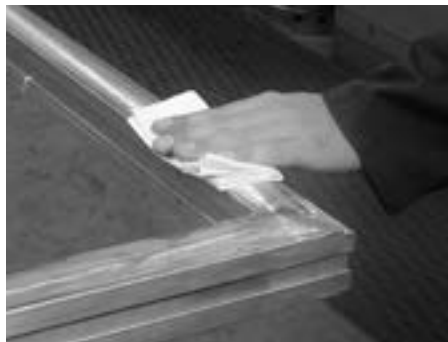
Klebeflächen bei Rahmen und Blech mit rückstandsfreiem Putzmittel reinigen (z.B. Aceton)
