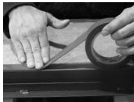
Klebeband auf Türflügel-Rahmen aufbringen
