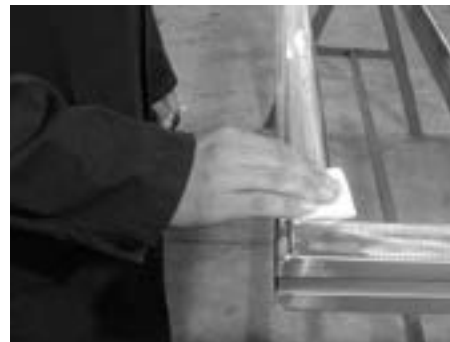
Anschliessend Klebeflächen bei Rahmen und Blech mit Primer (gemäss Angaben Klebebandhersteller) vorbehandeln
