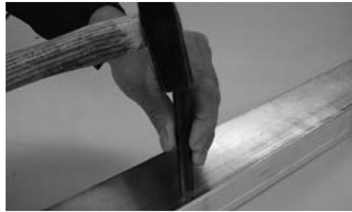
Einschlagen der Tüle mit Montagewerkzeug 499.318 und Stahlhammer (Achtung: Unterlagen verwenden)
