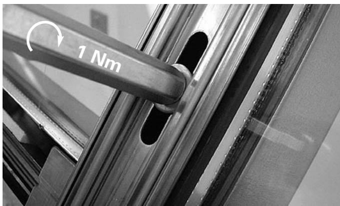
Abb. 99 Zentriermutter mit Akku-Schrauber montieren (Drehmoment 1 Nm)
