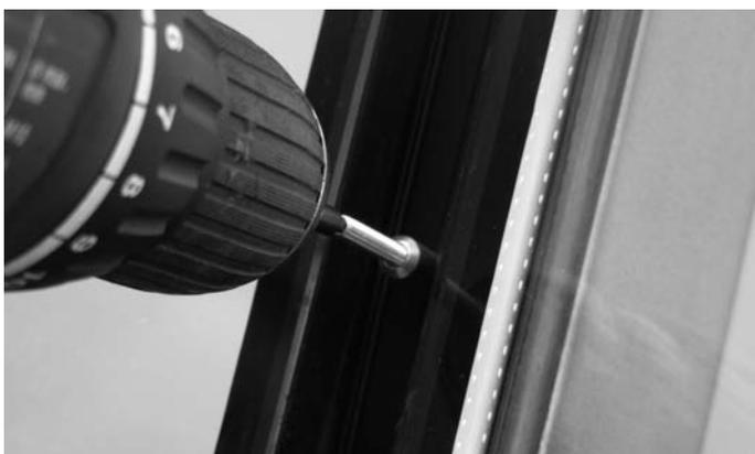
**Abb. 93a** Im Sparrenbereich M5-Gewindestifte in Brandschutzanker eindrehen
