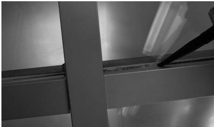
**Abb. 32** Silikonmasse in die Fuge pressen
