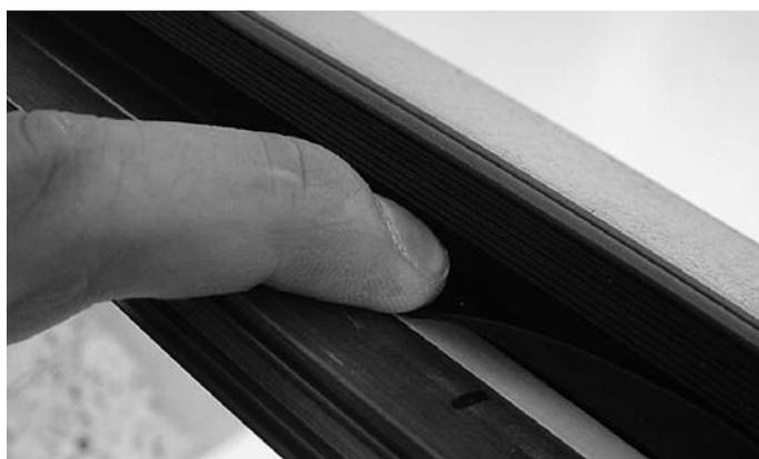
**Abb. 71** Dichtungslappen fest und gleichmässig andrücken
