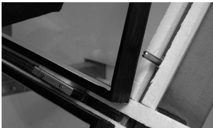
Abb. 22 Füllelement auf Glasauflagen absetzen und oben anlegen
