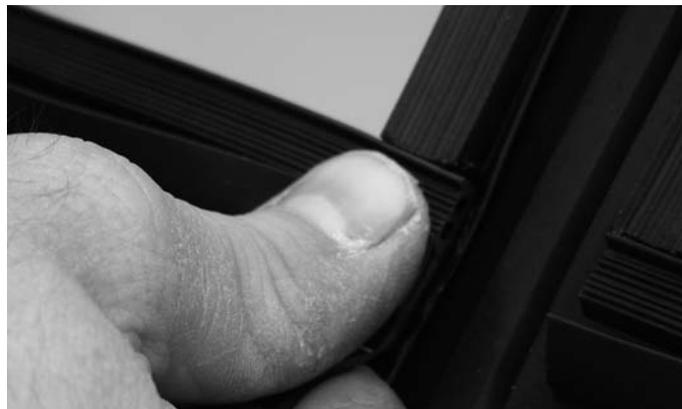
Abb. 59 Horizontaldichtung oben in Kreuzpunkt positionieren
