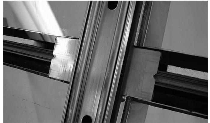
*Abb. 102 Schraubenüberstand min. 2 mm
