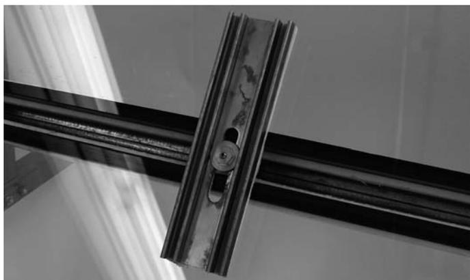
**Abb. 25** Füllelement mit Anpressprofil-Stück sichern
