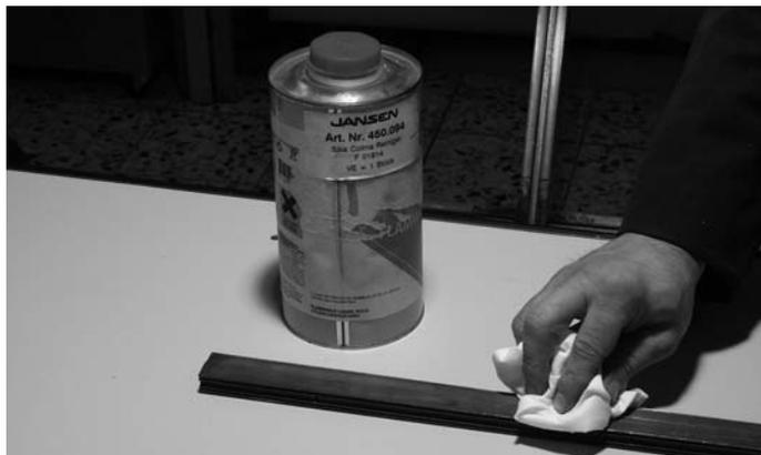
**Abb. 64** Riegel-Falzprofile mit Primer 450.094 reinigen
