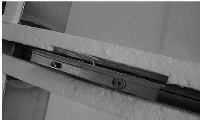
Abb. 20 Keramikfaserband im Bereich Glasauflage mittels Cutter ausklinken
