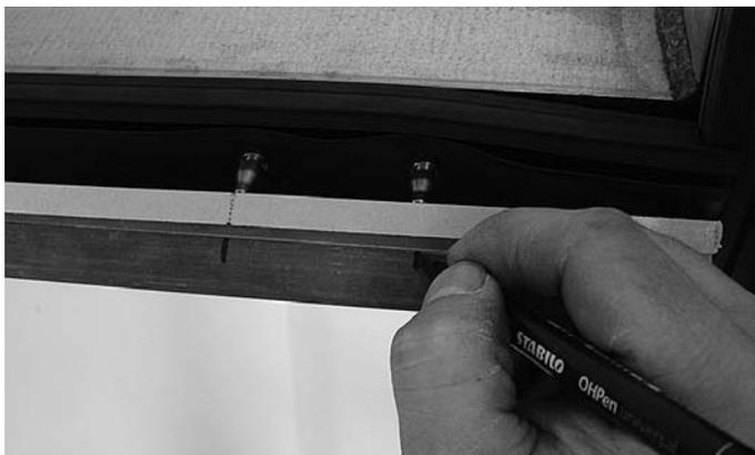
**Abb. 67** Position der Traganker auf dem Riegel-Falzprofil markieren
