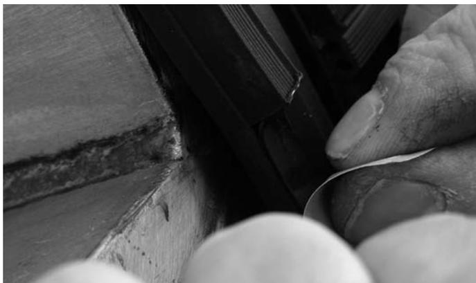
Abb. 58 Schutzfolie vom Butyl-Dichtstück abziehen
