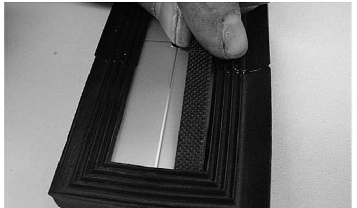
**Abb. 84** *Brandschutzlaminat-Streifen der Dichtung entlang anlegen*
