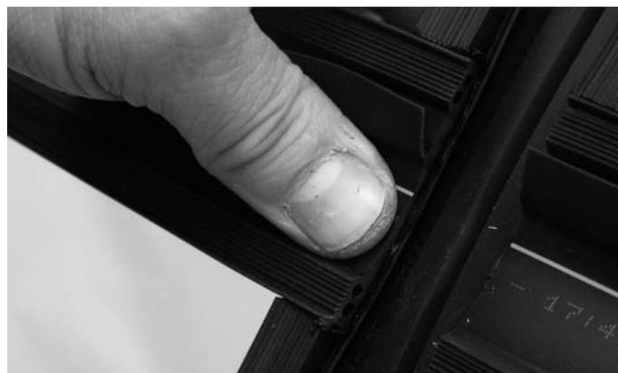
Abb. 61 Horizontaldichtung auf Butyl-Dichtstück andrücken
