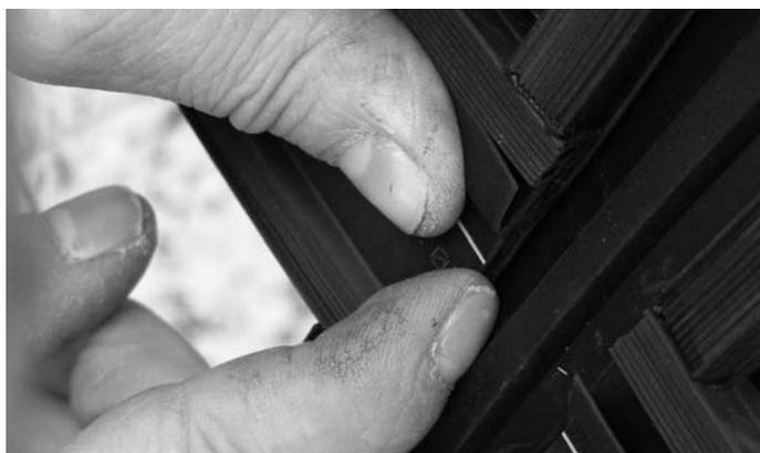
Abb. 62 Dichtlappen der Vertikal-Innendichtung seitlich andrücken
