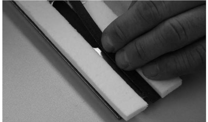
Abb. 15 Schutzfolie bei Brandschutzlaminat-Streifen ein Stück weit abziehen
