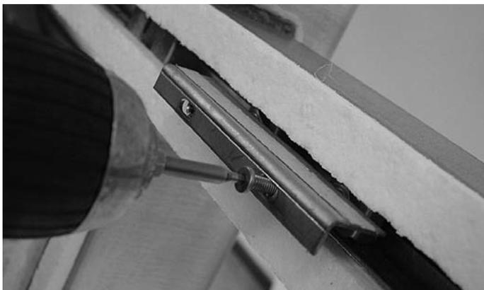
Abb. 19 Einsetzen und Befestigen der Glasauflagen mittels Schraube, auf Brandschutzanker zur Feldmitte
