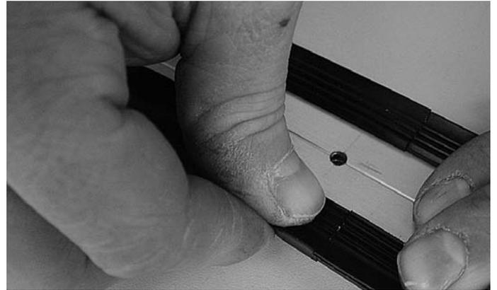
**Abb. 82** *Horizontaldichtung an Dichtungs-Formstück andrücken*
