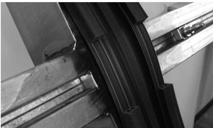
Abb. 38 Ausgeklinkte Kreuzpunkt-Dichtung
