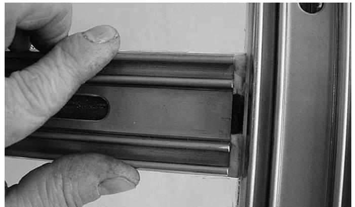
Abb. 29 Horizontales Anpressprofil anlegen. Seitliches Spiel gleichmässig verteilen.
