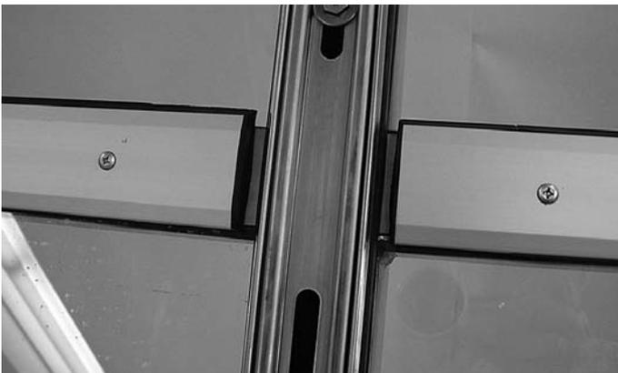
Abb. 106 Montierte Anschraubprofile im Kreuzpunkt
