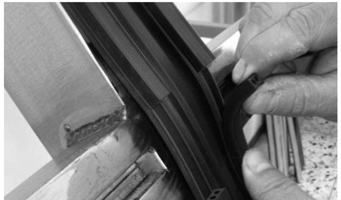
Abb. 37 Dichtungsteil abreißen
