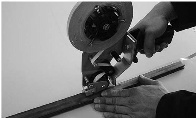
**Abb. 65** Klebeband mit Dispenser auftragen
