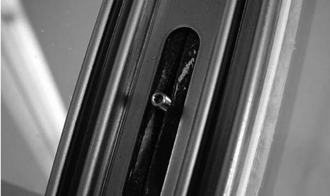
Abb. 26 Anpressprofile im Bereich der Langlöcher über die Gewindestifte drücken
