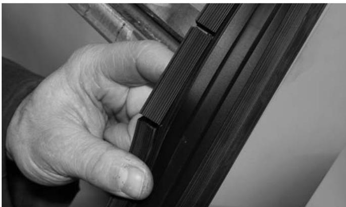
Abb. 41 Eingeschnittene Vertikaldichtung
