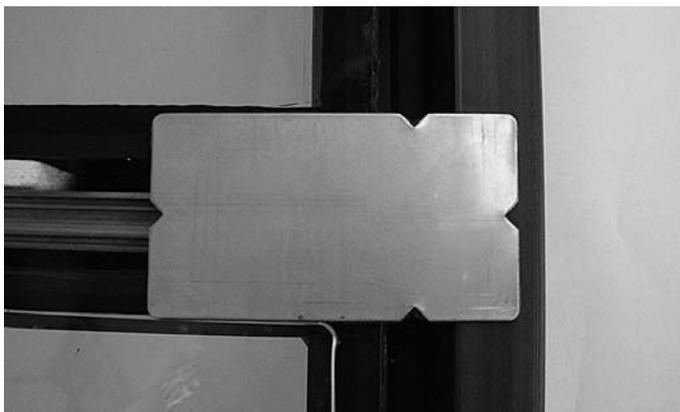
**Abb. 97** Endpunkt-Dichtungsplatte auf Glas und Randprofil montiert
