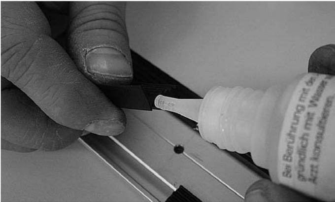
**Abb. 81** *Eingedrückte Horizontaldichtung mit Dichtungs-Formstück mittels Schnellkleber verkleben*
