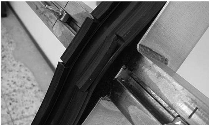
Abb. 36 Eingeschnittene Vertikaldichtung
