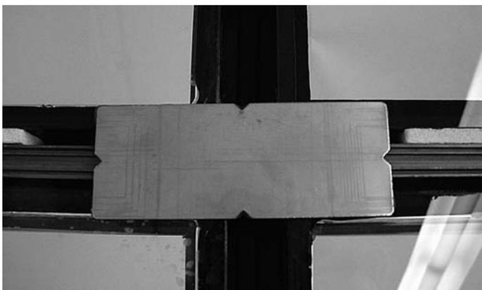
**Abb. 96** Kreuzpunkt-Dichtungsplatte auf Glaselement montiert
