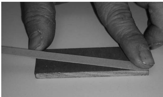
Abb. 87 Klebeband (455.493) auf Tragklotz (453.070) kleben
