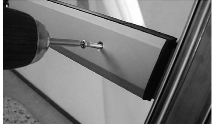
Abb. 105 Riegel-Anschraubprofil mit
