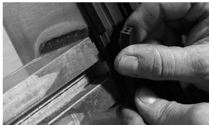
Abb. 42 Dichtungsteil abreißen
