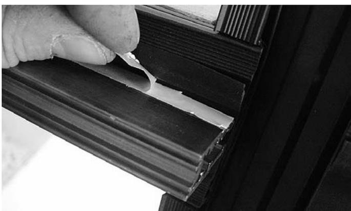
**Abb. 70** Klebeband-Schutzfolie abziehen
