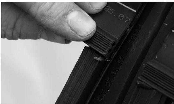
Abb. 60 Horizontaldichtung unten im Kreuzpunkt positionieren
