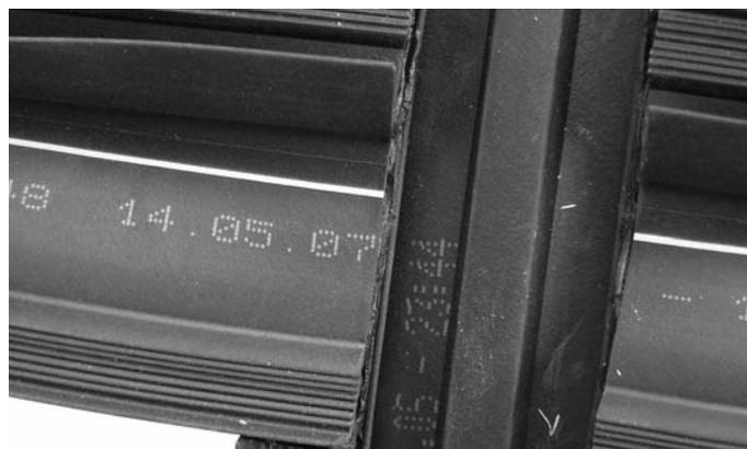
Abb. 63 Kreuzpunkt Vertikal-/Horizontaldichtung verklebt
