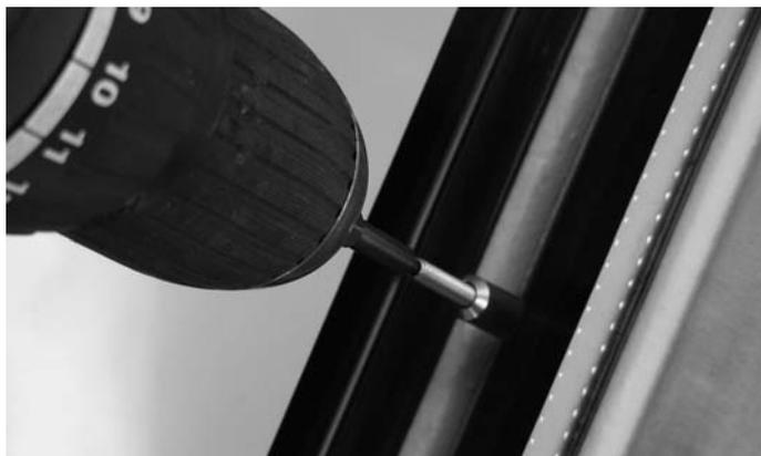
**Abb. 23** Eindrehen der Gewindestifte in Brandschutzanker
