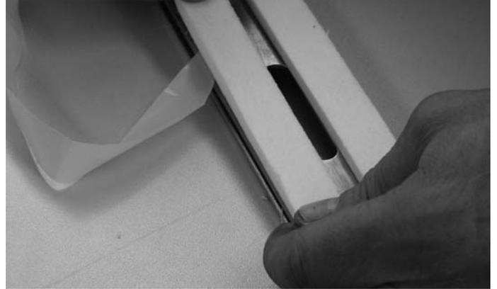
Abb. 12 Positionierung Keramikfaserband auf Rückseite des Anpressprofils
