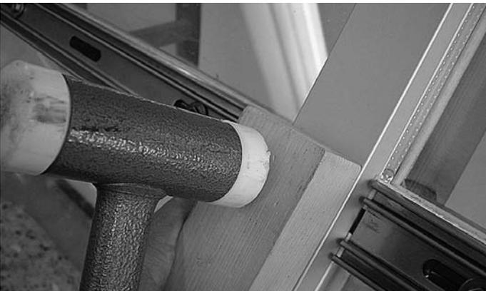
**Abb. 30** Aufschlagen der Abdeckprofile mit Schutzholz und Nylonhammer
