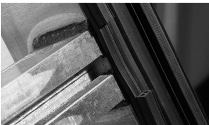
Abb. 43 Ausgeklinkte Endpunkt-Dichtung
