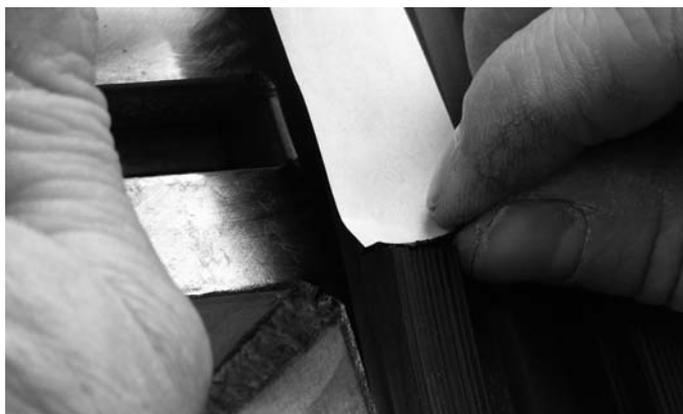
Abb. 54 Butyl-Dichtstück oben in der Ausklinkung ausrichten
