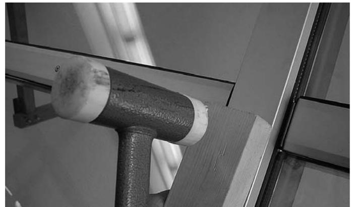
Abb. 107 Aufschlagen der vertikalen Abdeckprofile
