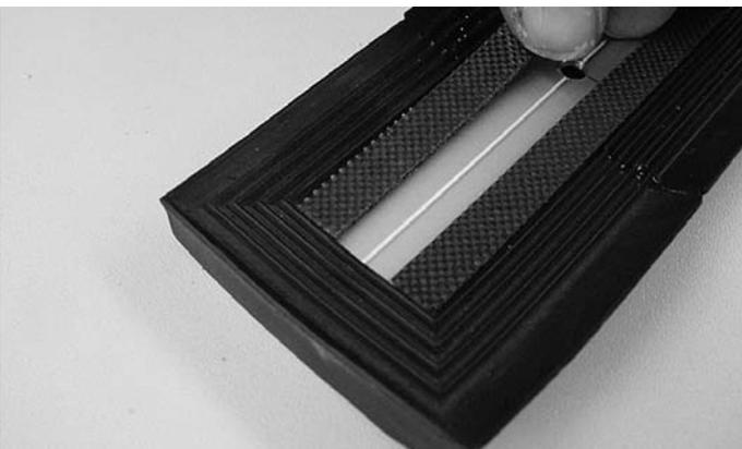
**Abb. 85** *Abschliessend Schutzfolie weiter abziehen und Brandschutzlaminat-Streifen fortlaufend andrücken.*
