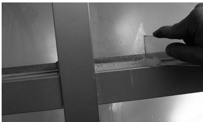
**Abb. 34** Silikon mit einem Kunststoffspachtel abziehen
