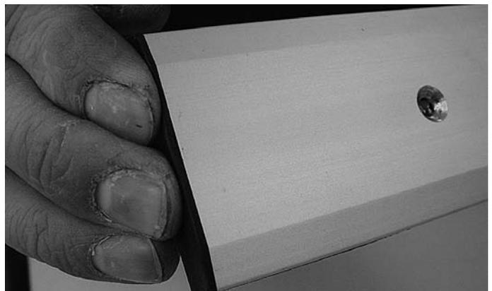
Abb. 79 Dichtungs-Formstück an Anschraubprofil andrücken
