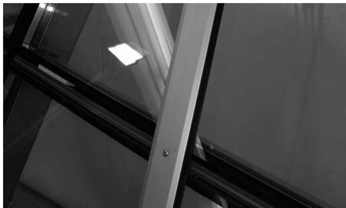
**Abb. 92** Füllelement z.B. mit Anschraubprofil sichern
