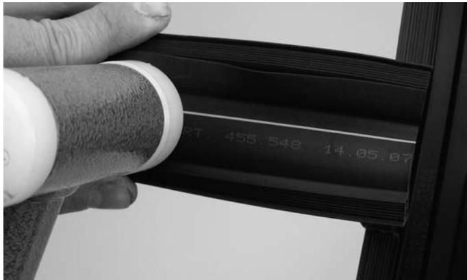
Abb. 50 Platzieren der Horizontaldichtung im Kreuzpunkt
