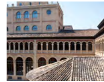
15 Informationsgebäude der Universität Zaragoza, Zaragoza/ES
