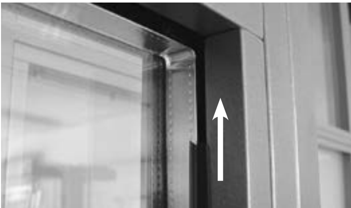
Eindrücken der Dichtung in Richtung Ecke Enfoncement du joint en direction de l'angle Pressing the gasket in the direction of the corner
