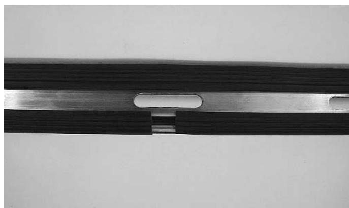
Abb. 23 Unterbrechung der unteren Horizontal-Aussendichtung für die Glasfalfz-Belüftung bei grossen Riegelbreiten.
