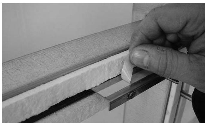
*Abb. 14 Abziehen der Klebband-Schutzfolie
