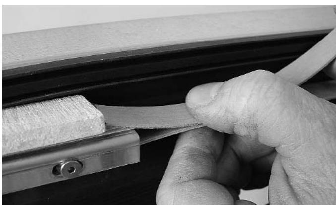
Abb. 49 Brandschutzlaminat oben zwischen Glasauflagen/Glasklötzten ankleben.
