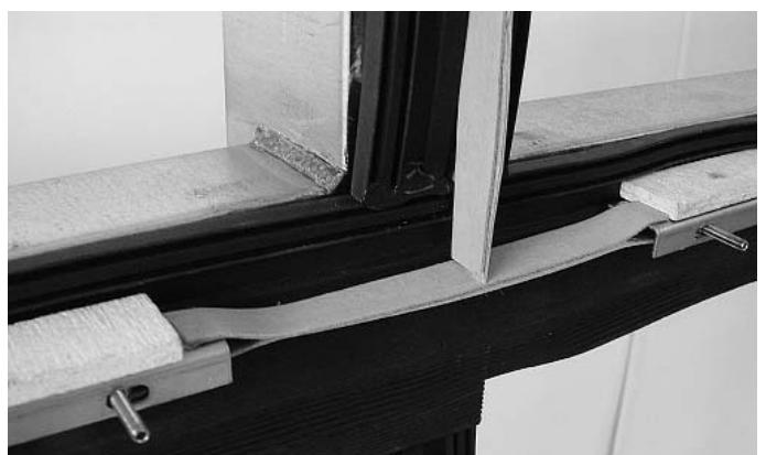
Abb. 52 Vertikales Brandschutzlaminat zwischengesetzt
