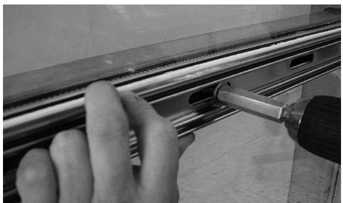
Abb. 22 Horizontales Anpressprofil festschrauben.
