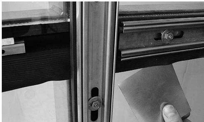
Abb. 37 Schneidunterlage (z.B. Inox-Blech 0,5 mm) unter Dichtungslappen schieben
