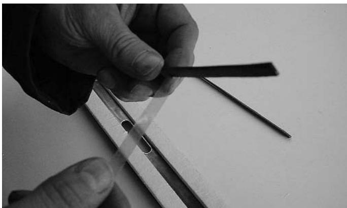
Abb. 26 Schutzfolie bei Brandschutzlaminat-Streifen ein Stück weit abziehen
