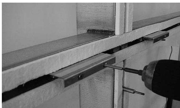
*Abb. 13 Eindrehen Gewindestift bei Glasauflagen
