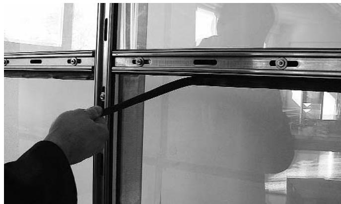
Abb. 40 Dichtungslappens abreissen
