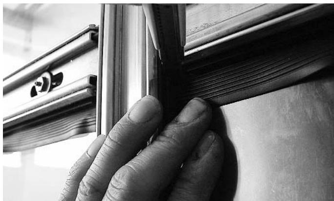
Abb. 39 Dichtungslappen horizontal kurz anschneiden
