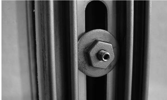
Abb. 19 M4-Spezial-Zentriermutter für die Montage der Anpressprofile. Überstand Gewindestift min. 2 mm.
