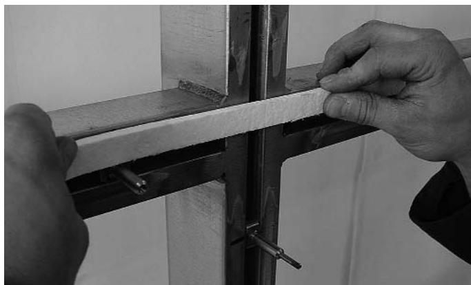
Abb. 3 Im Kreuzpunkt-Bereich werden die Keramikfaserbänder durchgehend aufgeklebt.
