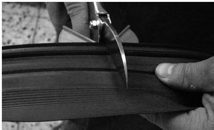
Abb. 1 Zuschnitt der Horizontaldichtung
