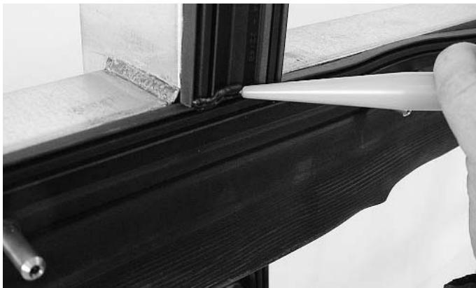
Abb. 14 Vertikaldichtung unten beim Dichtungsstoss zur Horizontaldichtung zusätzlich mit Dichtmasse\* abdichten.
