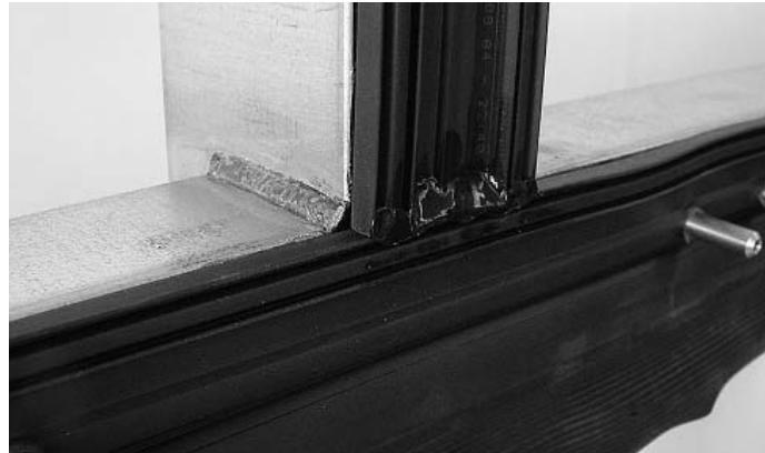
Abb. 17 Abgedichteter Dichtungsstoss im Riegelbereich oben
