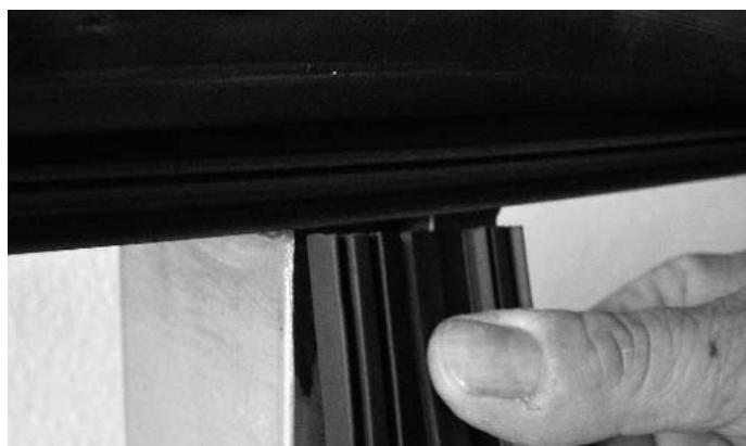
Abb. 13 Dichtung anlegen und satt andrücken
