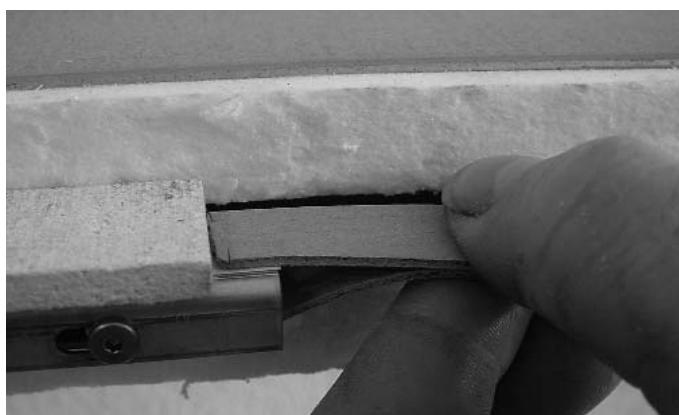
Abb. 31 Brandschutzlaminat oben zwischen Glasauflagen/ Glasklötzten ankleben
