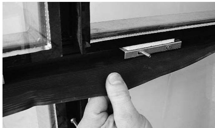
Abb. 31 Dichtungslappen der Horizontaldichtung über Füllelement legen und leicht nach unten ziehen
