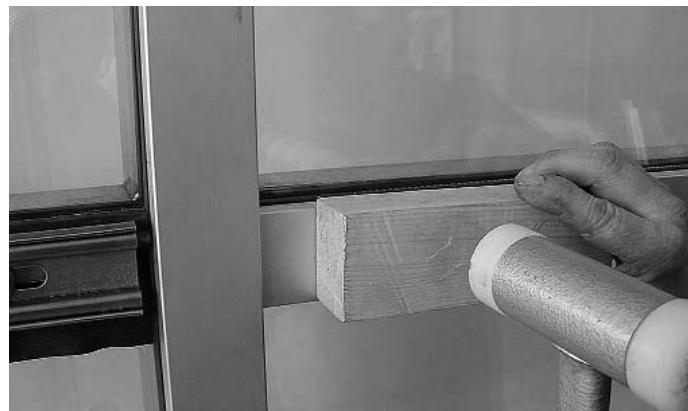
Abb. 42 Aufschlagen der horizontalen Abdeckprofile
