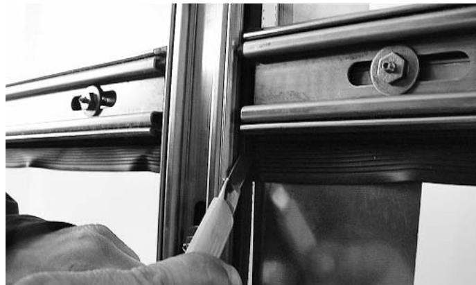
Abb. 38 Dichtungslappen entlang dem vertikalen Anpressprofil links und rechts anschneiden
