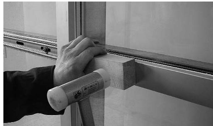
Abb. 24 Aufschlagen der horizontalen Abdeckprofile
