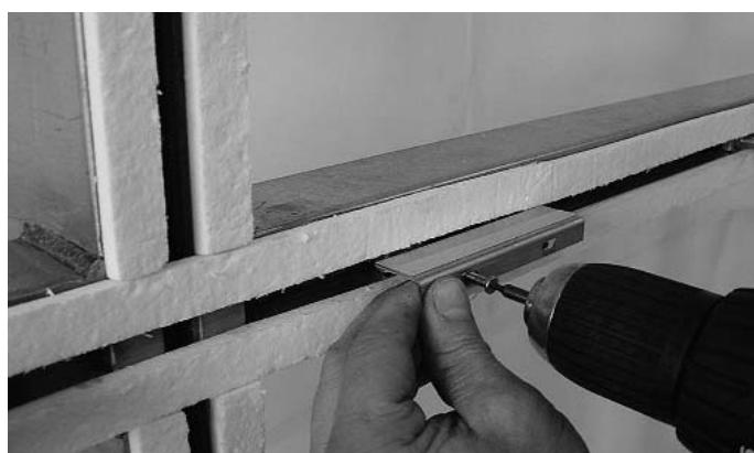
*Abb. 12 Einsetzen und Befestigen der Glasauflagen mittels
