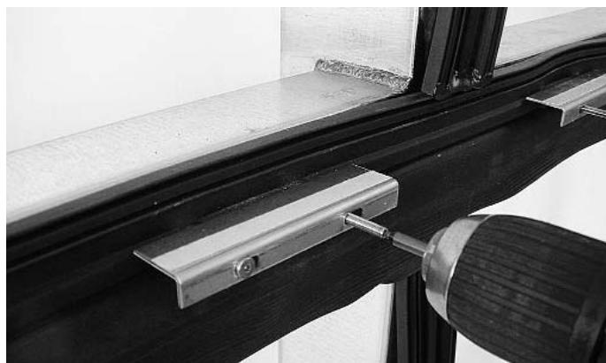
Abb. 27 Eindrehen Gewindestift bei Glasauflagen
