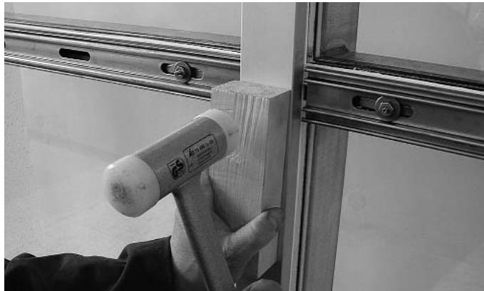
Abb. 23 Aufschlagen der vertikalen Abdeckprofile
