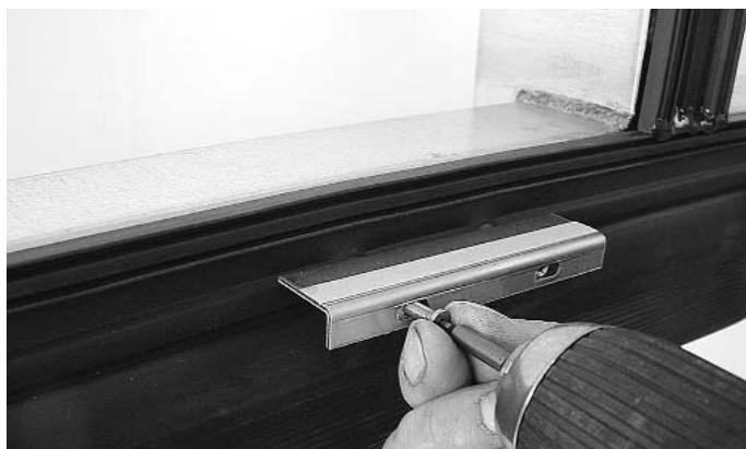
Abb. 26 Einsetzen und Befestigen der Glasauflagen mittels
