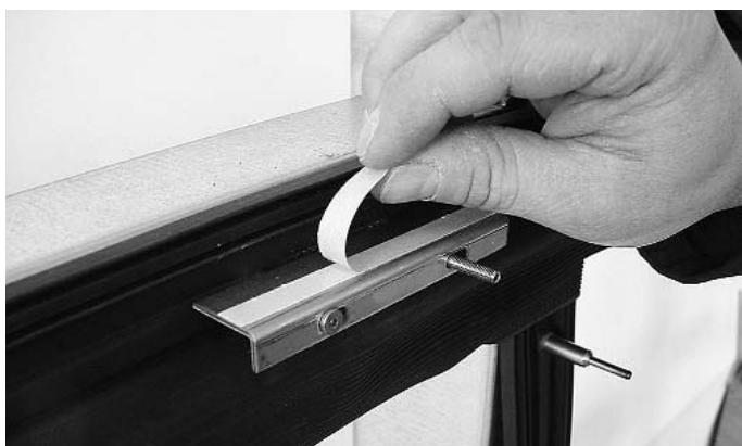
Abb. 28 Abziehen der Klebeband-Schutzfolie bei Glasauflagen
