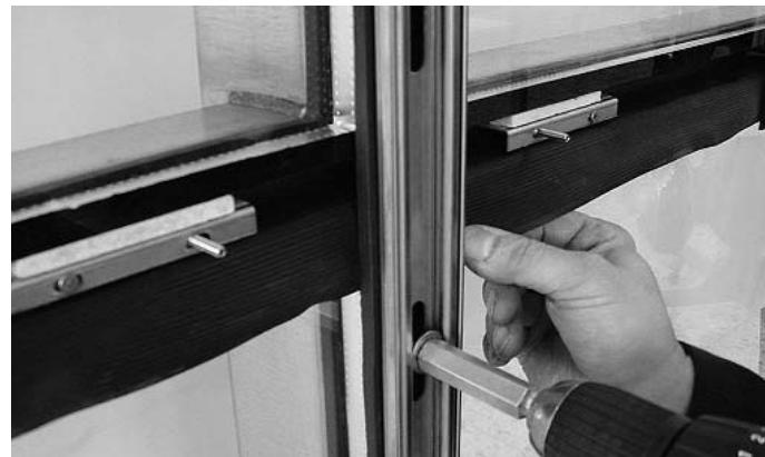
Abb. 34 Vertikale Anpressprofile anlegen und festschrauben. Bei den Riegel-Kreuzpunkten Dichtungslappen leicht nach unten ziehen.
