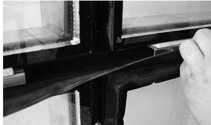
Abb. 30 Füllelement auf Glasaufklager absetzen und oben anlegen (Dichtungslappen der Horizontal-Dichtung leicht anheben)
