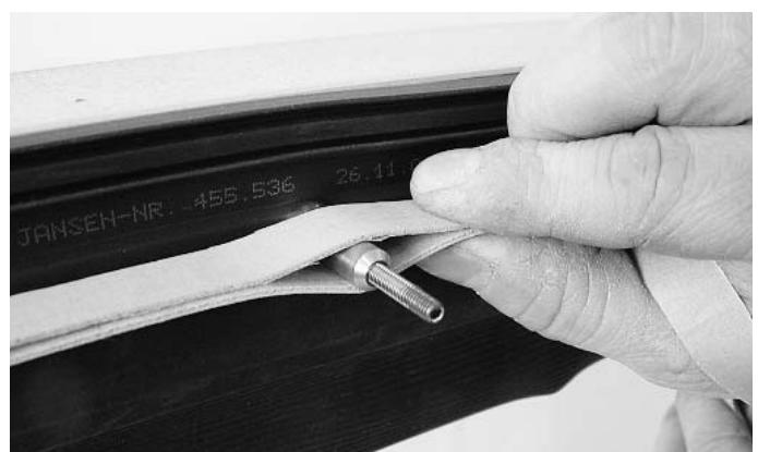
Abb. 50 Brandschutzlaminat im Bereich Brandschutzanker
