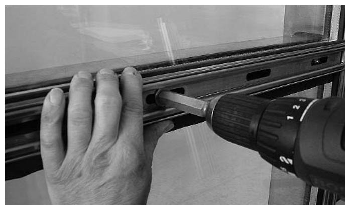
Abb. 36 Horizontales Anpressprofil festschrauben. Anziehen mit Spezialschlüssel 499.254, **Drehmoment 1 Nm\***.
