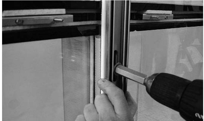
Abb. 20 Vertikale Anpressprofile anlegen und festschrauben
