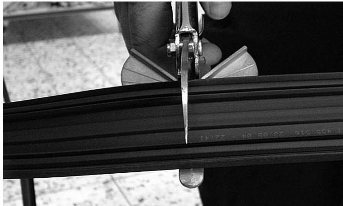
Abb. 3 Zuschnitt der Vertikaldichtung
