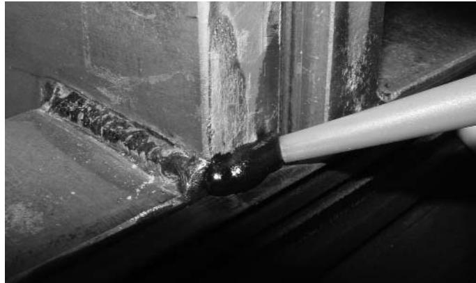
Abb. 10 Vertikaldichtung unten mit Dichtmasse\* verkleben.
