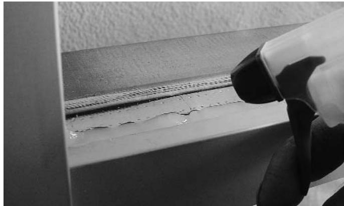
Abb. 37 Dichtstoff-Fuge mit Abglättmittel besprühen
