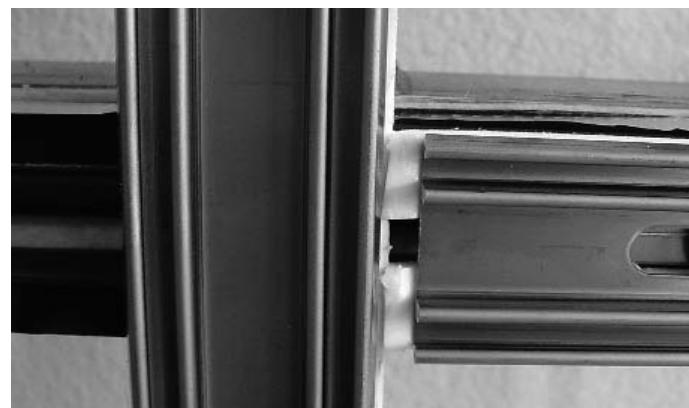
Abb. 21 Horizontales Anpressprofil anlegen und darauf achten, dass das Spiel beidseitig gleichmäßig verteilt ist.
