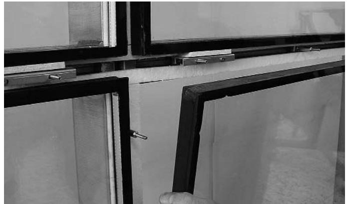
Abb. 17 Füllelement oben anlegen
