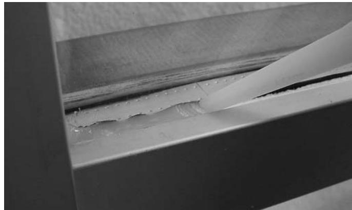
Abb. 35 Auftragen der Dichtungsmasse
