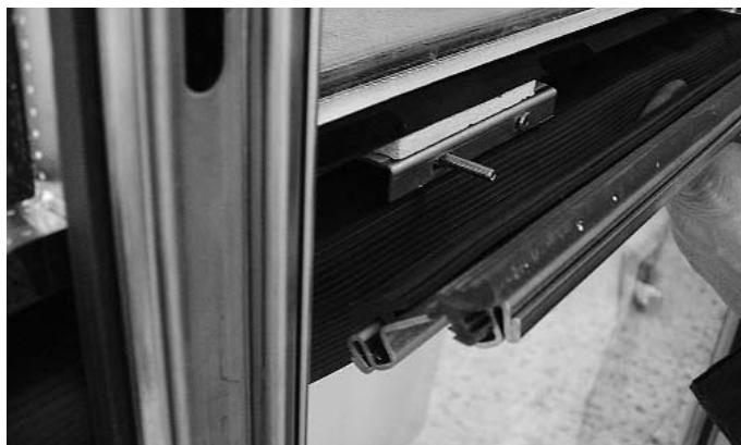
Abb. 35 Horizontales Anpressprofil aufsetzen. Darauf achten, dass der Dichtungslappen auf der ganzen Länge nach unten verläuft.
