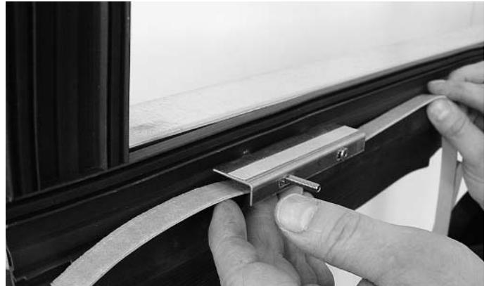
Abb. 48 Brandschutzlaminat im Riegel-Bereich unten an Glasauflager resp. Brandschutzanker kleben.
