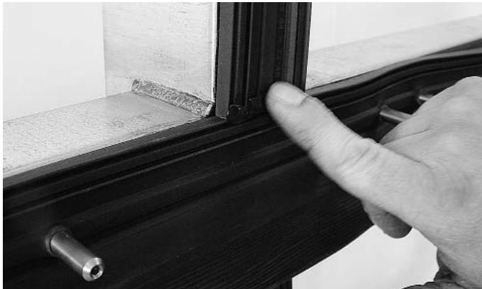
Abb. 16 Ausstreichen der Dichtmasse\* im Bereich Vertikal-/ Horizontaldichtung
