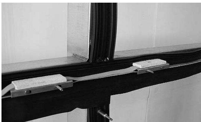
Abb. 51 Brandschutzlaminat im Kreuzpunkt-Bereich horizontal durchlaufend
