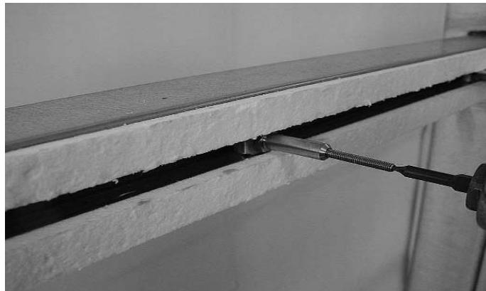
*Abb. 11 Eindrehen der Gewindestifte in Brandschutzzanker
