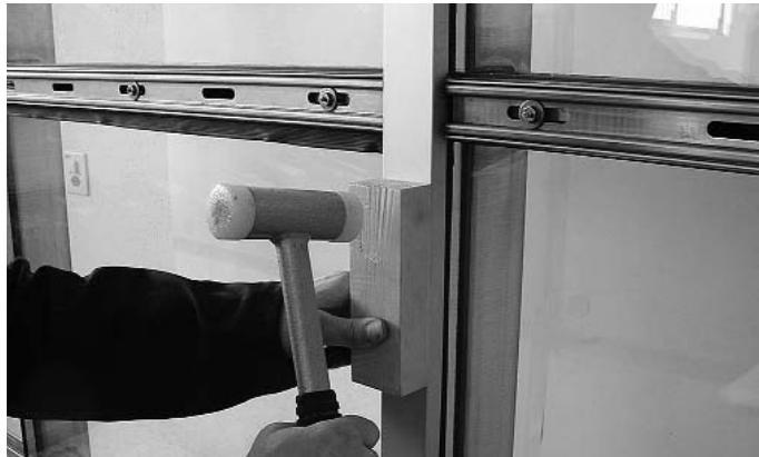
Abb. 41 Aufschlagen der vertikalen Abdeckprofile
