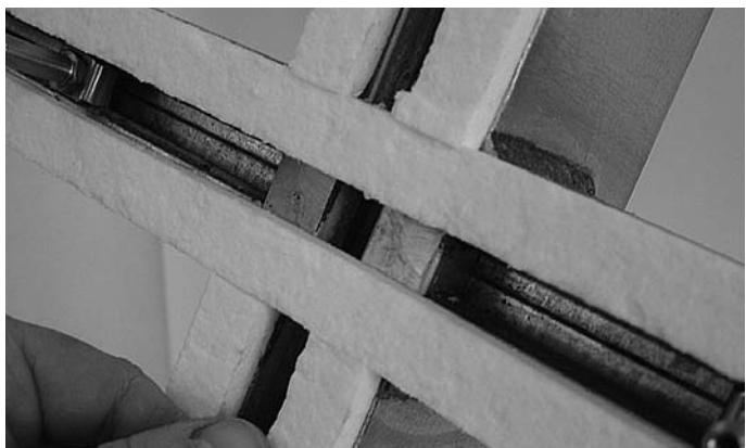
Abb. 11 Die vertikalen Keramikfaserbänder werden im Kreuzpunkt-Bereich zwischengesetzt.
