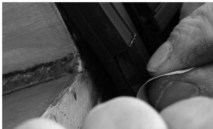
Abb. 58 Schutzfolie vom Butyl-Dichtstück abziehen
