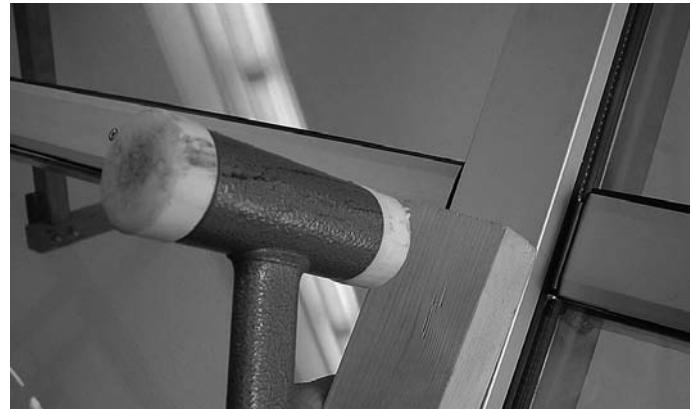
Abb. 107 Aufschlagen der vertikalen Abdeckprofile mit Schutzhölz und Nylonhammer
