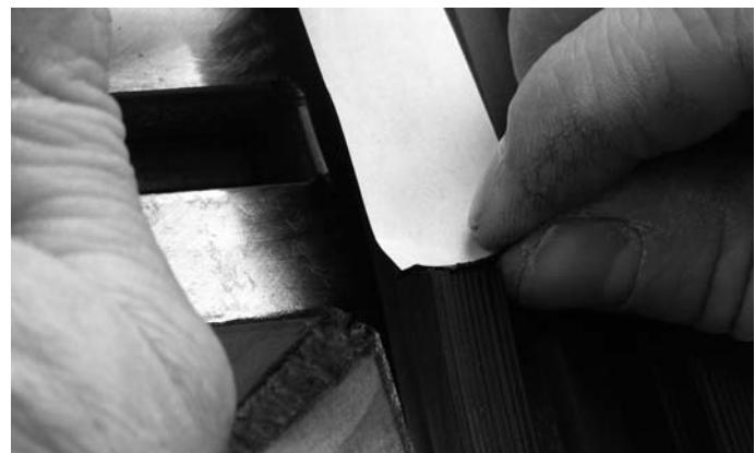
Abb. 55 Butyl-Dichtstück unten in der Ausklinkung ausrichten
