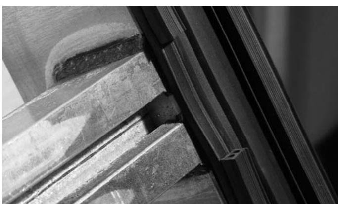
Abb. 43 Ausgeklinkte Endpunkt-Dichtung
