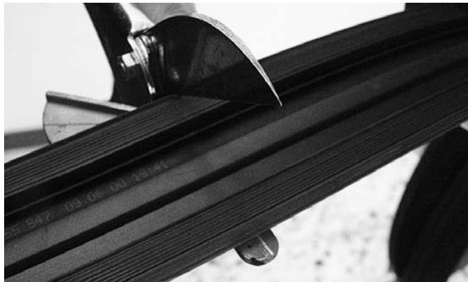
Abb. 28 Zuschnitt der Vertikaldichtung
