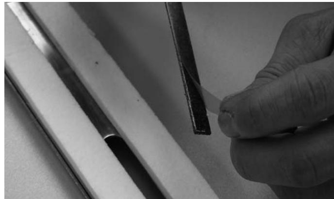
Abb. 15 *Schutzfolie bei Brandschutzlaminat-Streifen ein Stück weit abziehen*
