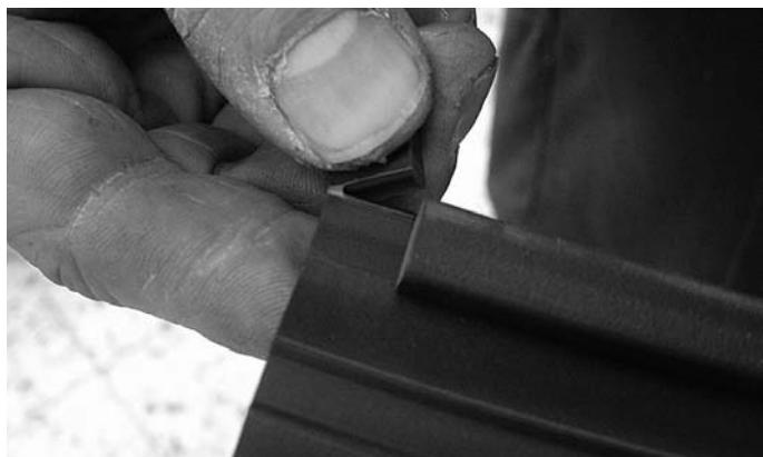
Abb. 48 Dichtungssteil auf Rückseite abreissen
