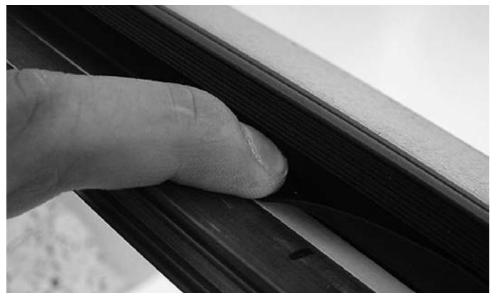
Abb. 71 Dichtungslappen fest und gleichmäßig andrücken
