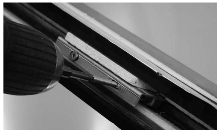
Abb. 24 Eindrehen Gewindestifte bei Glasauflagen
