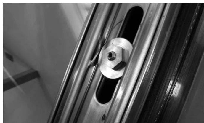
Abb. 101 Montierte Zentriermutter
