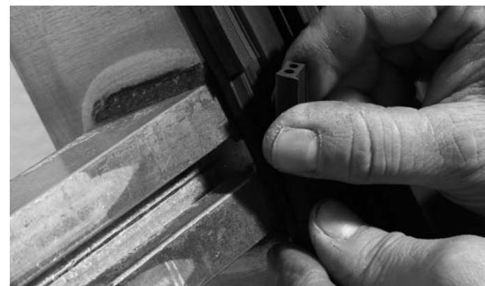
Abb. 42 Dichtungsteil abreissen
