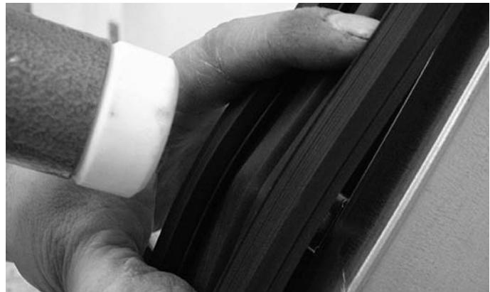
Abb. 31 Aufschlagen der Dichtung mittels Nylonhammer
