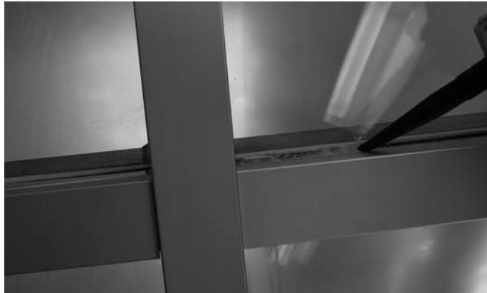
Abb. 32 Silikonmasse in die Fuge pressen
