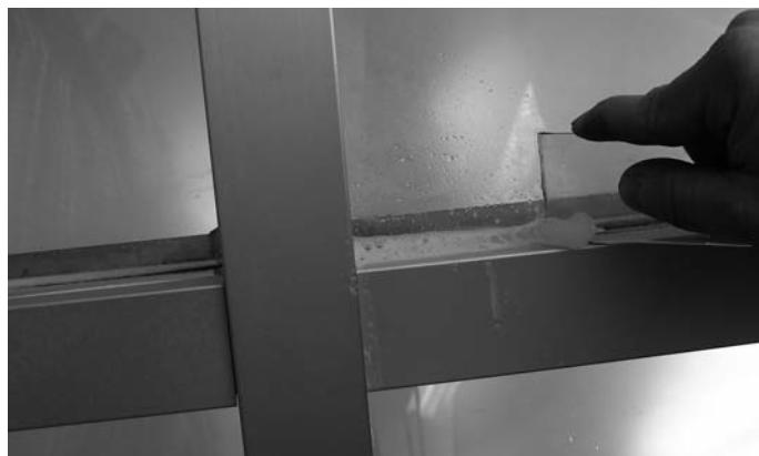
Abb. 34 Silikon mit einem Kunststoffspachtel abziehen
