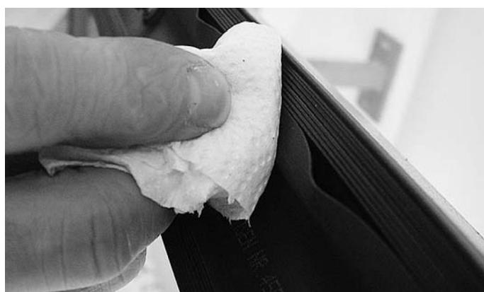
Abb. 66 Dichtungslappen der Horizontaldichtung mit Primer reinigen
