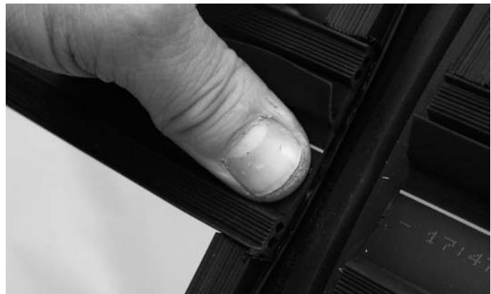
Abb. 61 Horizontaldichtung auf Butyl-Dichtstück andrücken
