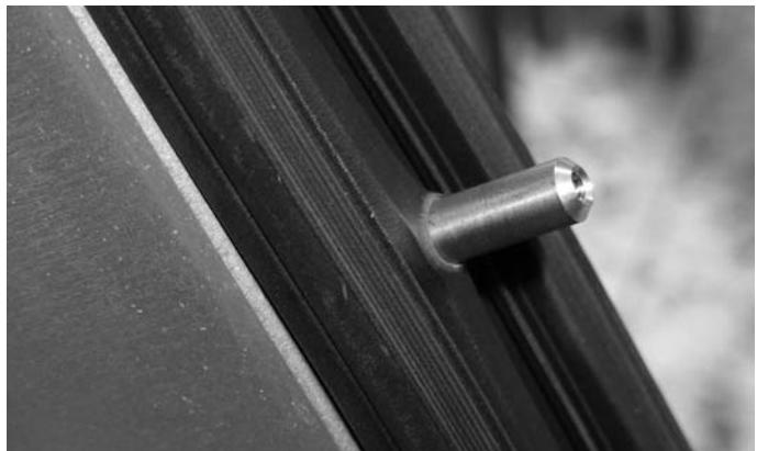
Abb. 33 Leichte Wölbung im Bereich der Brandschutzanker
