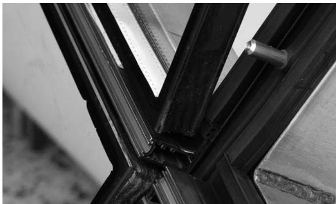
Abb. 91 Füllelement auf Glasauflager absetzen und oben anlegen
