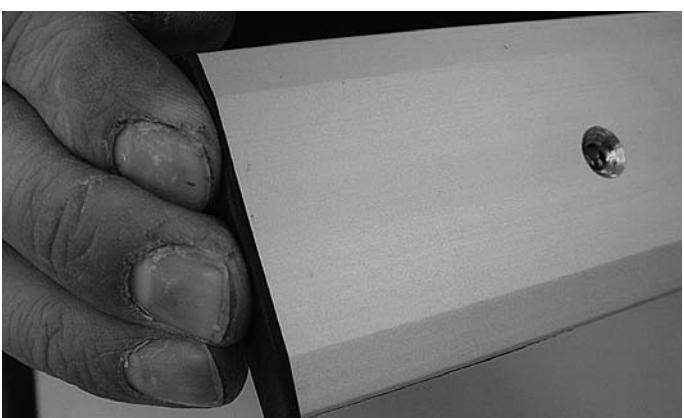
Abb. 79 Dichtungs-Formstück an Anschraubprofil andrücken
