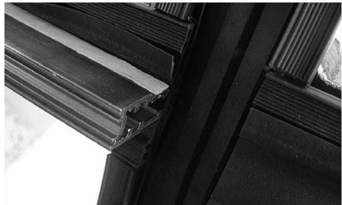
Abb. 69 Das Riegel-Falzprofil muss seitlich bündig mit der Horizontaldichtung aufgeschlagen werden
