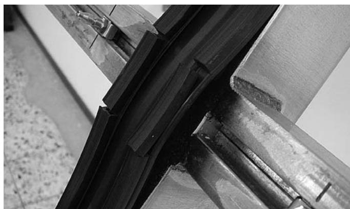
Abb. 36 Eingeschnitte Vertikaldichtung
