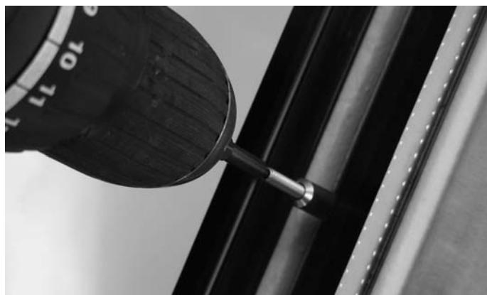
Abb. 23 Eindrehen der Gewindestifte in Brandschutzanker
