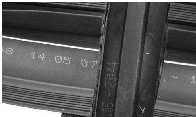
Abb. 63 Kreuzpunkt Vertikal-/Horizontaldichtung verklebt
