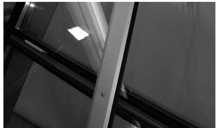
Abb. 92 Füllelement z.B. mit Anschraubprofil sichern
