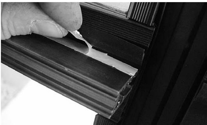
Abb. 70 Klebeband-Schutzfolie abziehen
