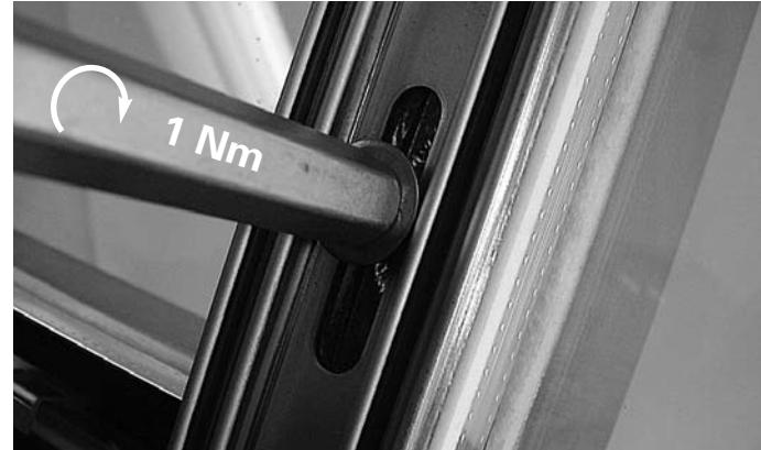
Abb. 27 Anpressprofil mittels Zentriermutter und Spezialschlüssel 499.254 anziehen,
