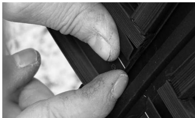
Abb. 62 Dichtlappen der Vertikal-Innendichtung seitlich andrücken
