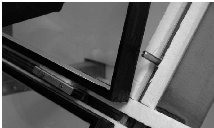
Abb. 22 Fülllelement auf Glasauflagen absetzen und oben anlegen
