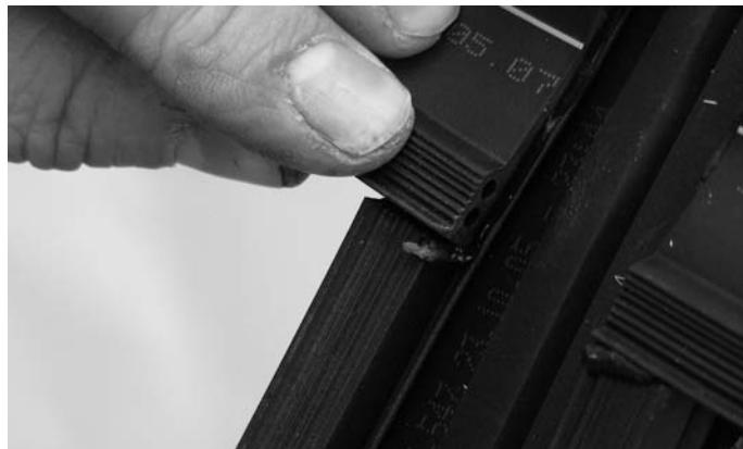
Abb. 60 Horizontaldichtung unten im Kreuzpunkt positionieren
