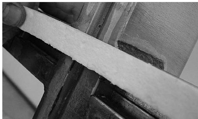
Abb. 10 Im Kreuzpunkt-Bereich werden die Keramikfaserbänder durchgehend aufgeklebt.
