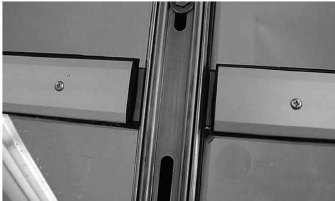
Abb. 106 Montierte Anschraubprofile im Kreuzpunkt
