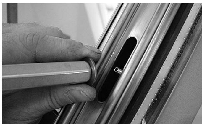
Abb. 98 Zentriermutter aufsetzen
