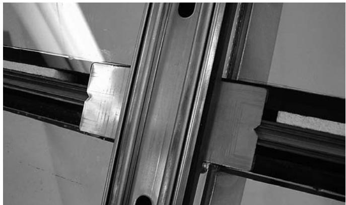
Abb. 103 Kreuzpunkt-Dichtungsplatte mit Anpressprofil
