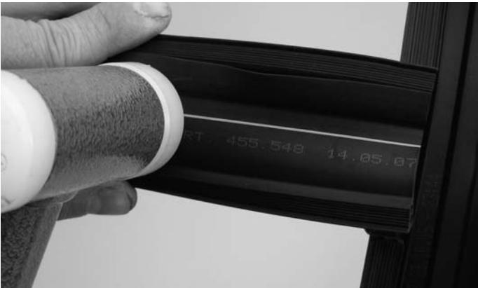
Abb. 51 Mit Nylonhammer aufschlagen/perforieren
