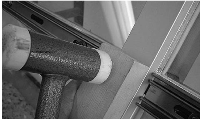
**Abb. 30 Aufschlagen der Abdeckprofile mit Schutzhölzern und Nylonhammer**
