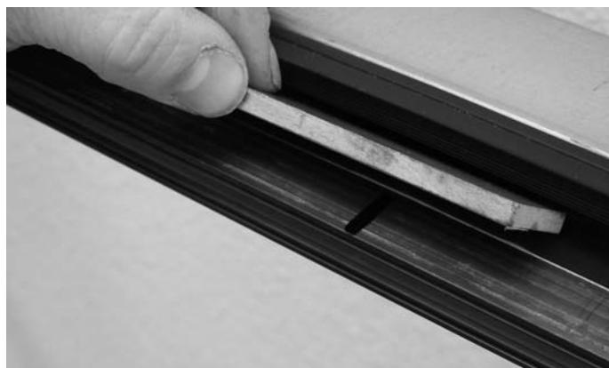
Abb. 89 Tragklotz über Traganker mit Klebeband aufkleben
