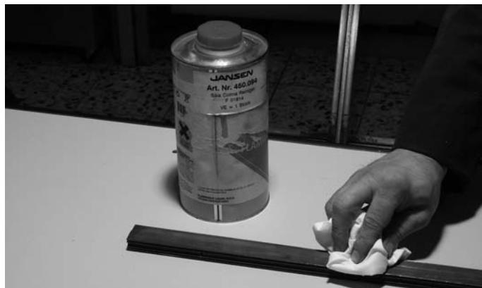
Abb. 64 Riegel-Falzprofile mit Primer 450.094 reinigen
