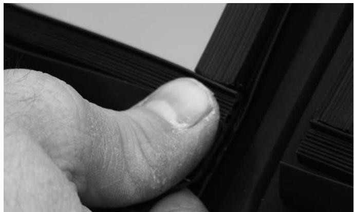
Abb. 59 Horizontaldichtung oben in Kreuzpunkt positionieren
