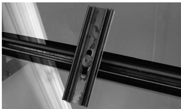
Abb. 25 Füllelement mit Anpressprofil-Stück sichern
