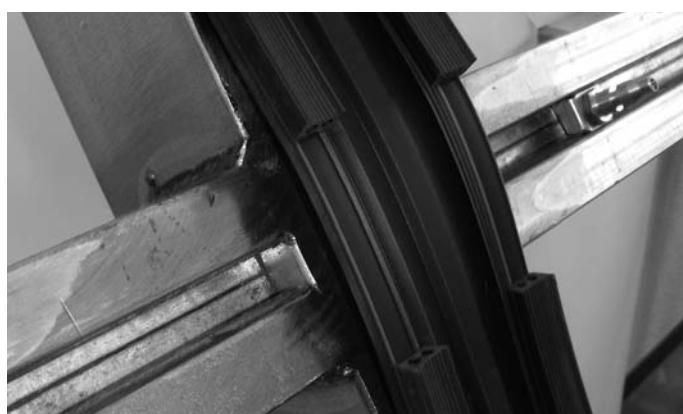
Abb. 38 Ausgeklinkte Kreuzpunkt-Dichtung
