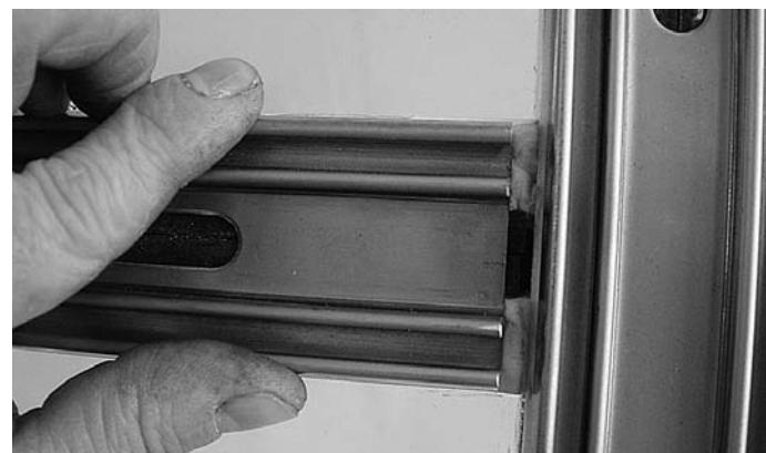
Abb. 29 Horizontales Anpressprofil anlegen.
