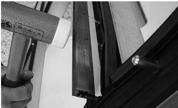
Abb. 68 Riegel-Falzprofil ausrichten und mit Nylon-Hammer aufklipsen
