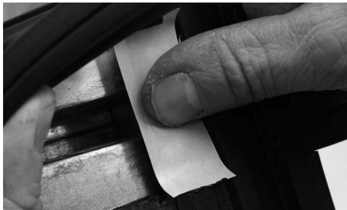
Abb. 56 Butyl-Dichtstück U-förmig eindrücken
