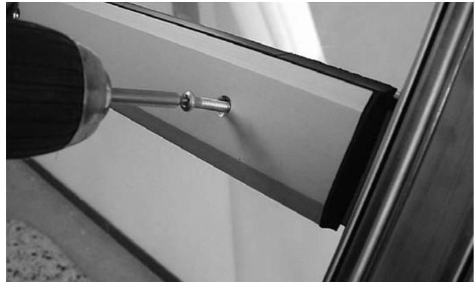
Abb. 105 Riegel-Anschraubprofil mit SR1-Selbstbohrschraube 452.496 anschrauben
