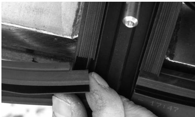
Abb. 50 Platzieren der Horizontaldichtung im Kreuzpunkt
