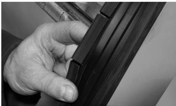
Abb. 41 Eingeschnitte Vertikaldichtung
