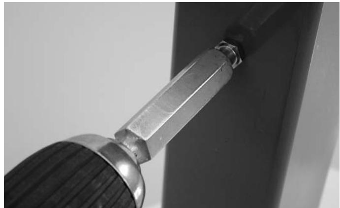
Abb. 26 Anziehen der Schraubbolzen resp. Schraub-Traganker mit Akku-Bohrschrauber (Drehmoment ca. 4-5 Nm)
