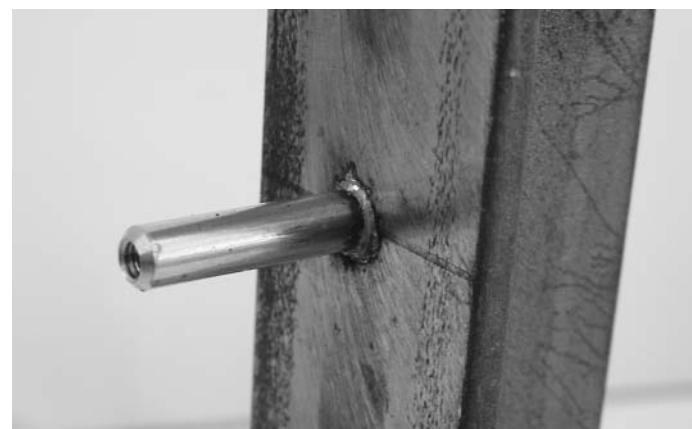
Abb. 8 Ansicht Schweissbolzen am Pfosten
